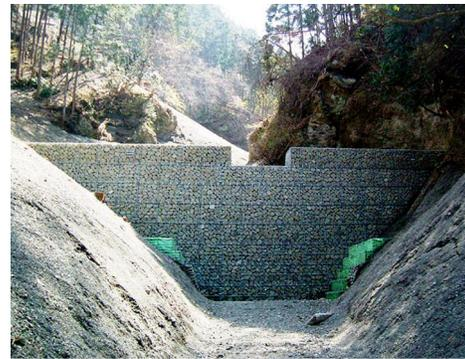
写真1 鋼製組立網 (H=9m)
