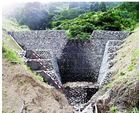
写真1 鋼製組立網写真（H=8.4m）
